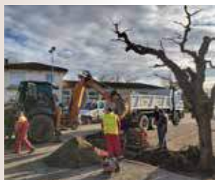
FÉVRIER 2021 Travaux du ralentisseur.
