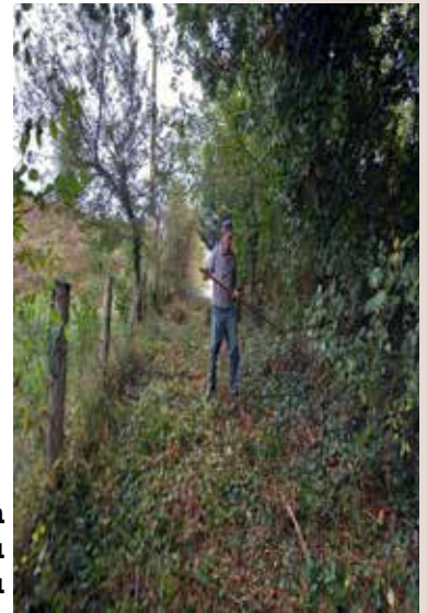
Un bénévole en pleine action lors du déblaiement du chemin des Lavandières.
