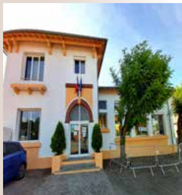
Façade de l'école repeinte.
